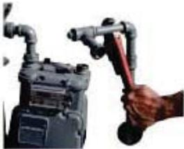
5. Retire la tubería que queda después del medidor.
