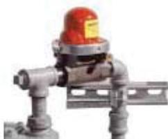
12. Termine de instalar el sistema de tubería del medidor con la válvula sísmica PSP.
