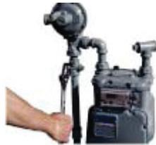
2. Cierre el gas en la válvula de entrada del medidor. No use una llave de tubos.
