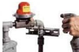
16. Aplique una mano de pintura a toda la tubería nueva para evitar la corrosión.
