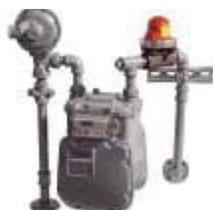
13. **Mientras el gas está todavía desconectado, abra la válvula sísmica. No abrir si hay presión de gas.**
