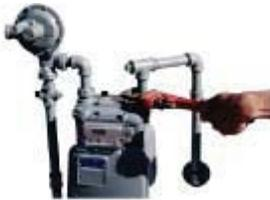
3. Afloje la unión del medidor.
