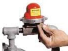
14. Abra el paso de gas en la válvula de entrada del medidor. No use una llave de tubos. Nota: Abra lentamente la válvula de gas para evitar que se dañe el regulador.
